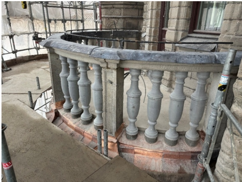
Balkong återställd med nytt tätskikt, kopparbeslagning samt nya balusterdockor monterade.
