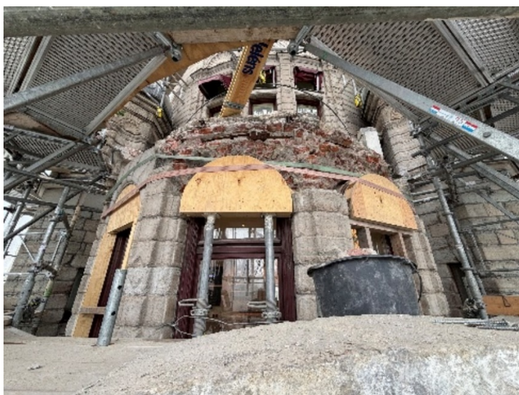
Konstruktionssmide hade rostat och tryckt ut stenfascaden.
